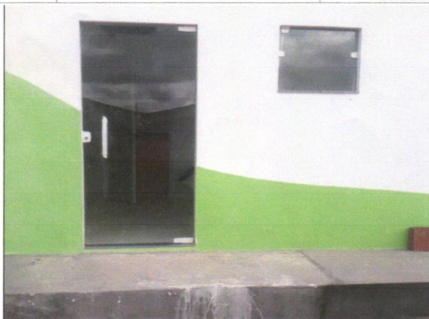
Foto 19 -Porta em vidro temperado 10mm, incolor, inclusive ferragens de fixação e instalação, exclusive puxador
