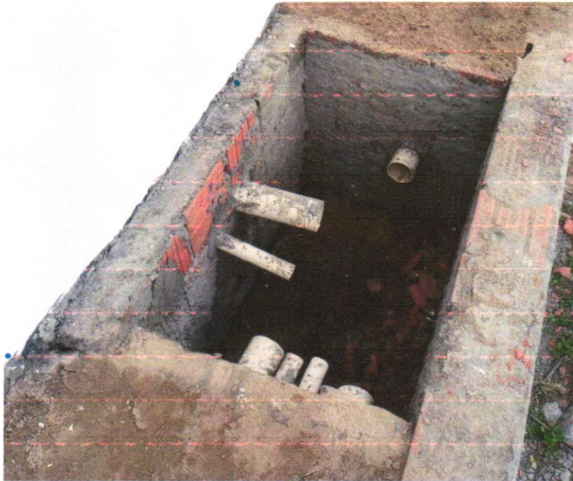
Foto 09 - Sumidouro paredes com blocos cerâmicos 6 furos e dimensões internas de 1,75 x 1,00 x 1,00 m
