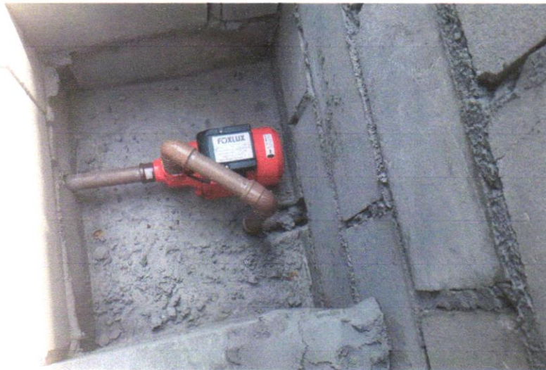
Foto 21 - BOMBA CENTRÍFUGA, MONOFÁSICA, 0,5 CV OU 0,49 HP, HM 6 A 20 M, Q 1,2 A 8,3 M3/H -
