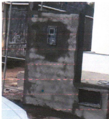
FOTO 02 – MASSA ÚNICA, PARA RECEBIMENTO DE PINTURA, EM ARGAMASSA TRAÇO 1:2:8 PREPARO MANUAL, APLICADA MANUALMENTE EM FACES INTERNAS DE PAREDES, ESPESSURA DE 10MM, COM EXECUÇÃO DE TALISCAS. AF_06/2014
