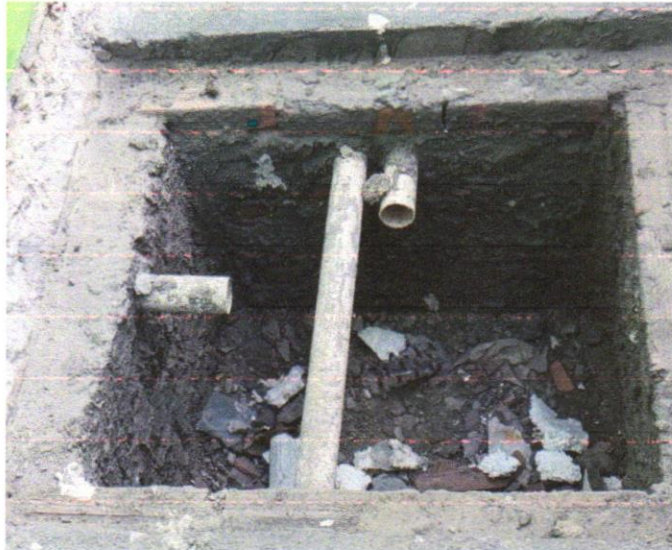
Foto 07 -Caixa de inspeção 0,30 x 0,30 x 0,40m
